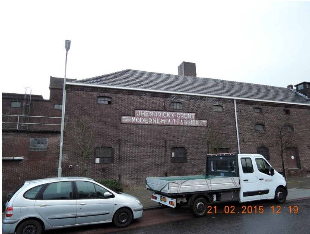
Foto onderzoeksteam, voormalige moutfabriek, 21 februari 2015
