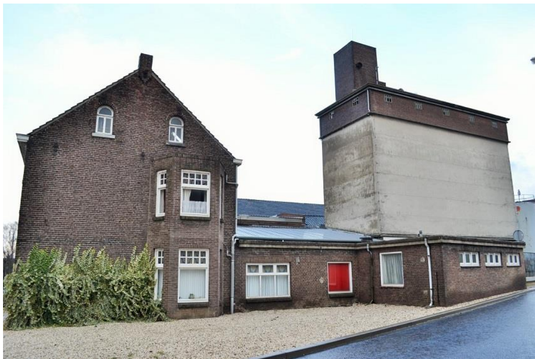
Foto onderzoeksteam, voormalige moutfabriek, 21 februari 2015
