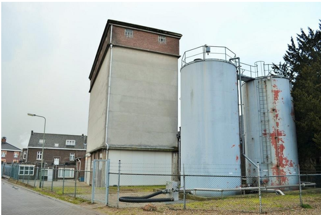
Foto onderzoeksteam, voormalige moutfabriek, 21 februari 2015
