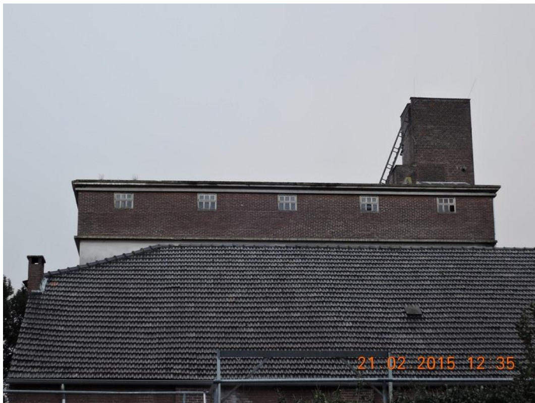
Foto onderzoeksteam, voormalige moutfabriek, 21 februari 2015
